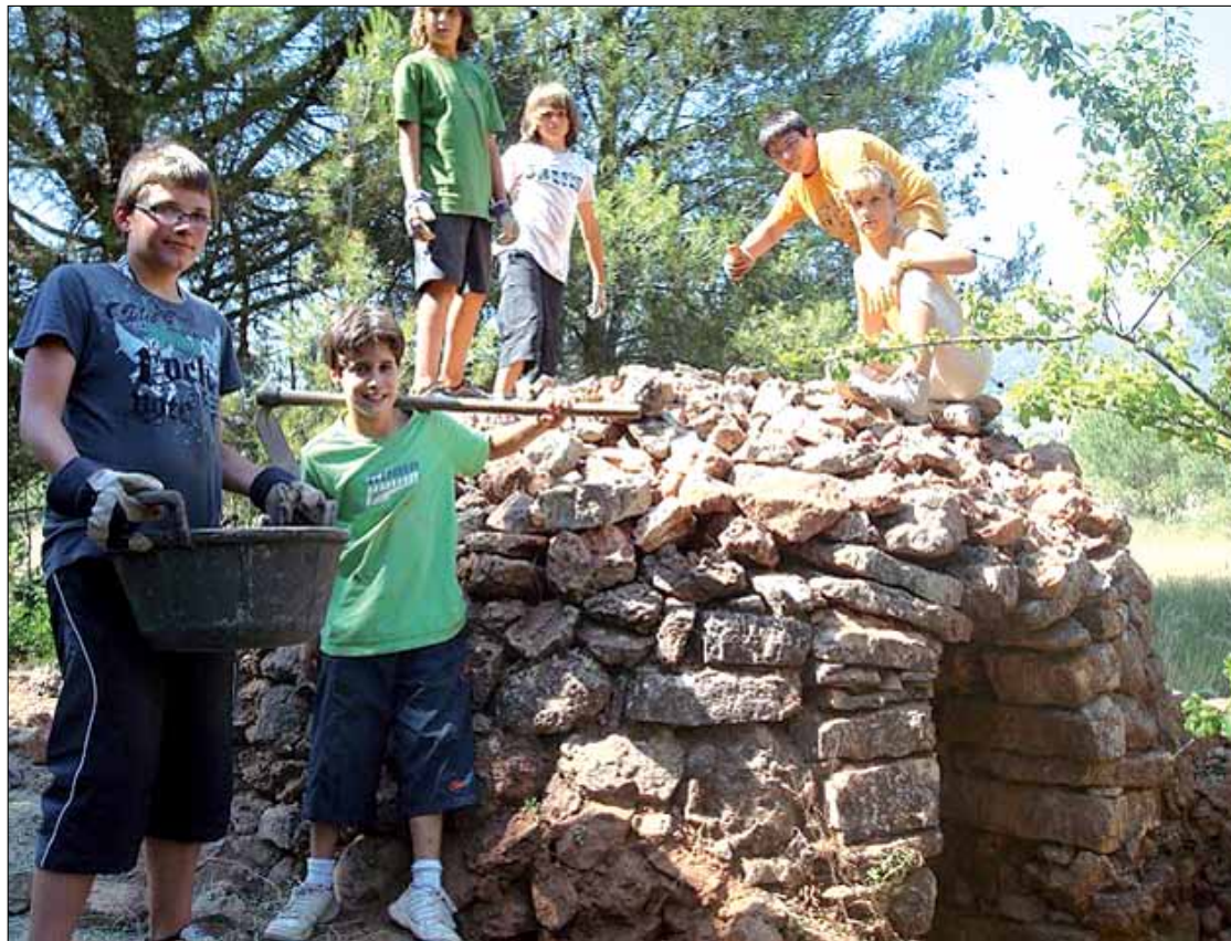
Restauración de una barraca de viña con la técnica de la piedra seca
